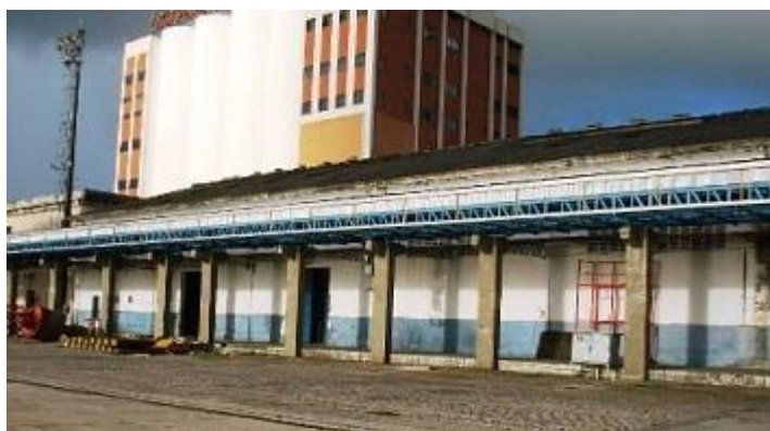
Fotografia 16 - Armazém nº 02 – lado do cais
