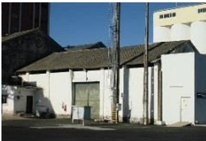
Fotografia 15 - Galpão nº 02 – lado do cais
