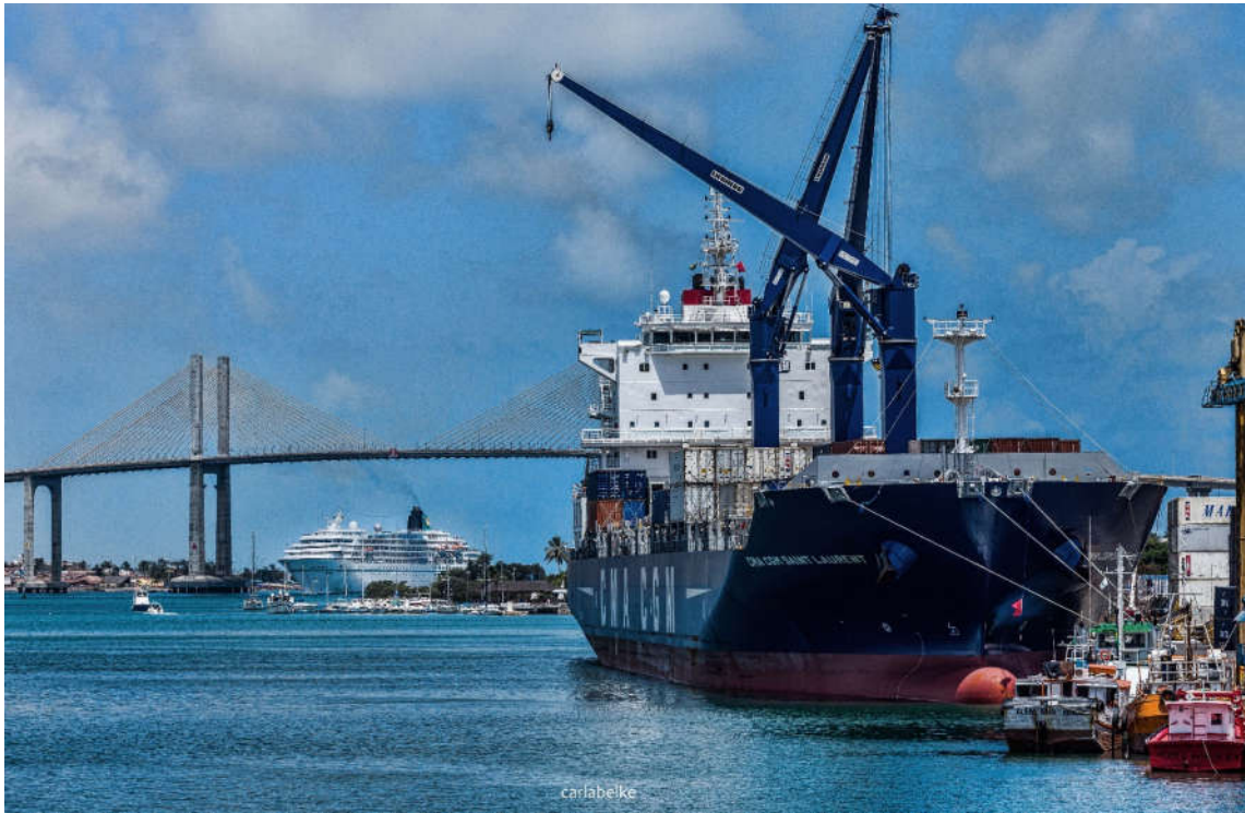
Vista do Porto de Natal para a Ponte Newton Navarro. Foto: Carla Belke
