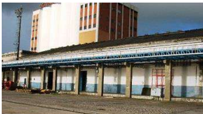
Fotografia 16 - Armazém nº 02 – lado do cais
