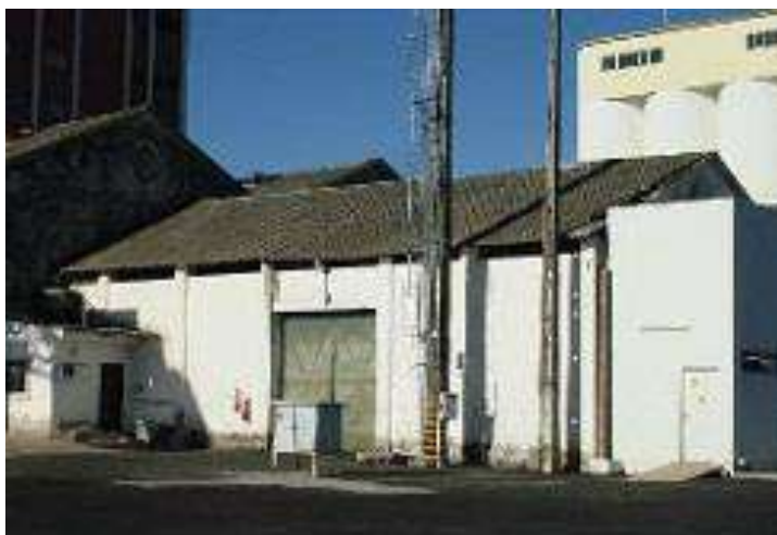
Fotografia 15 - Galpão nº 02 – lado do cais
