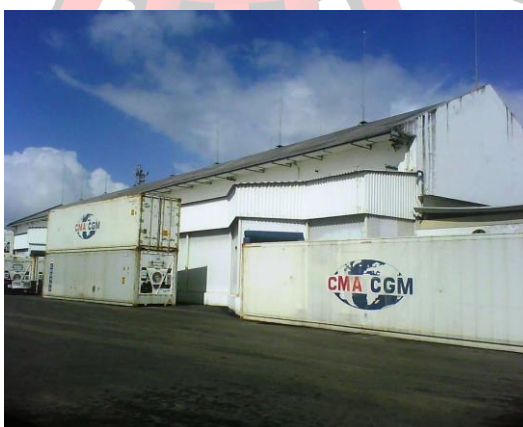
Foto 7. Armazém 4 próximo ao frigorífico.
