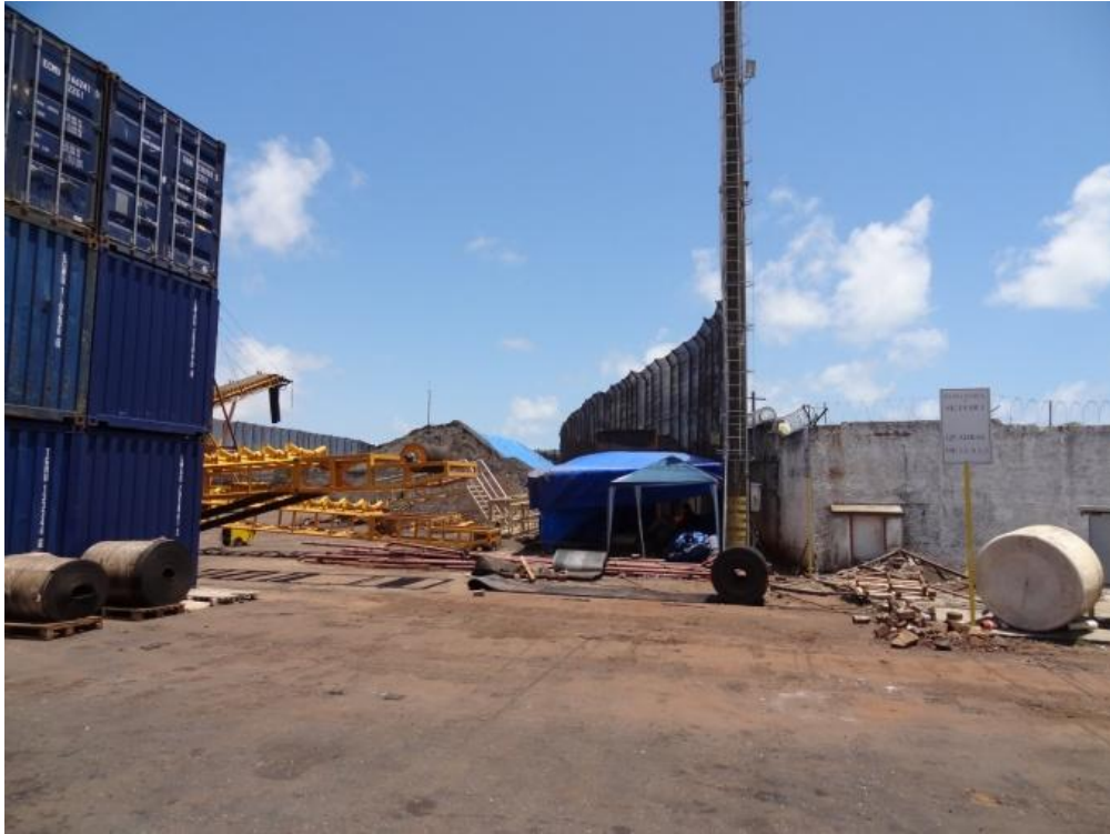
Figura 35 - Depósito temporário de resíduos
