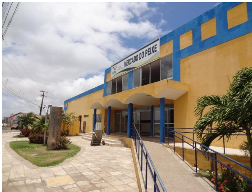
Figura 43 - Mercado do Peixe próximo do depósito de minério de ferro
