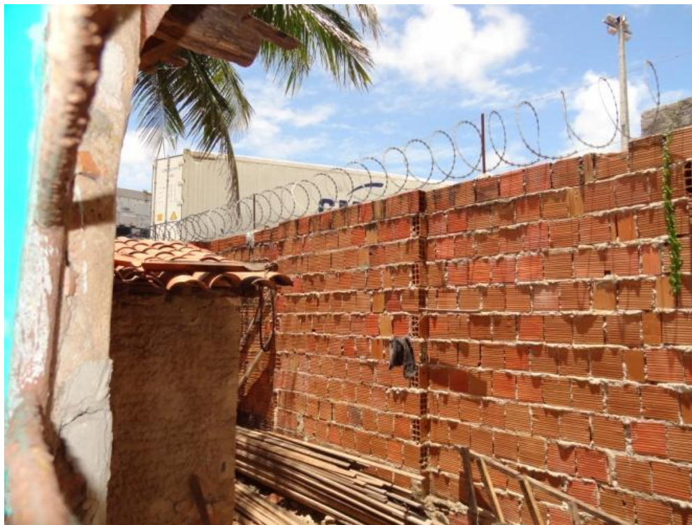
Figura 46 - Residência ao lado do depósito de minério de ferro
