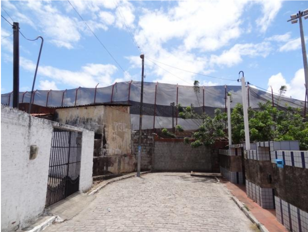
Figura 44 - Vista externa dos fundos do depósito de minério de ferro
