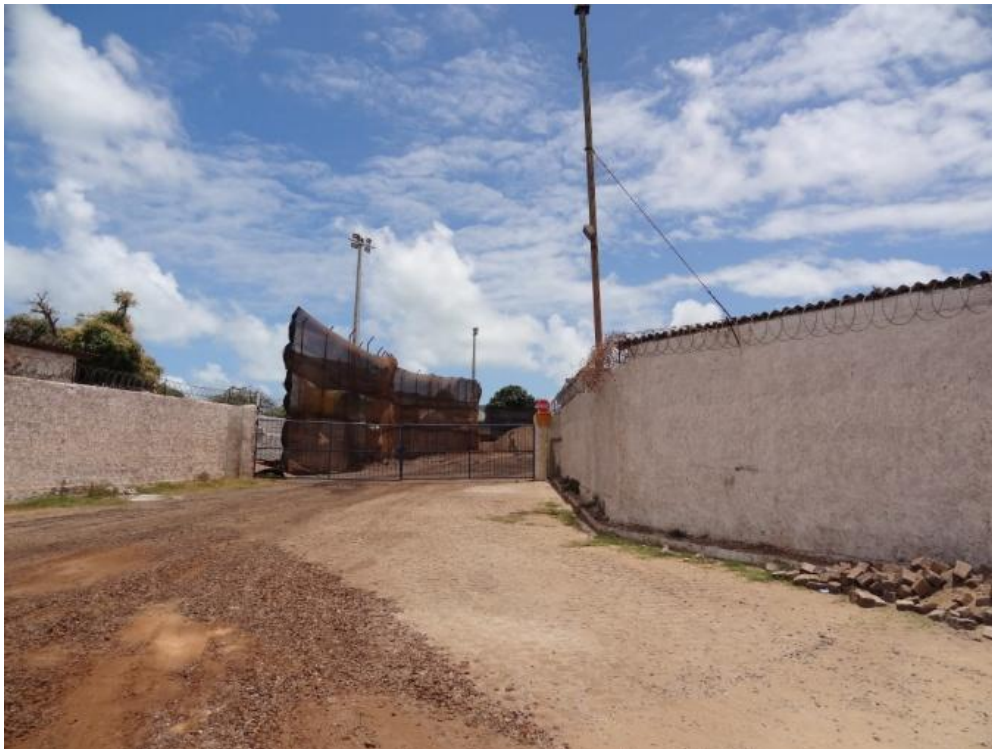
Figura 41 - Entrada do depósito de minério de ferro
