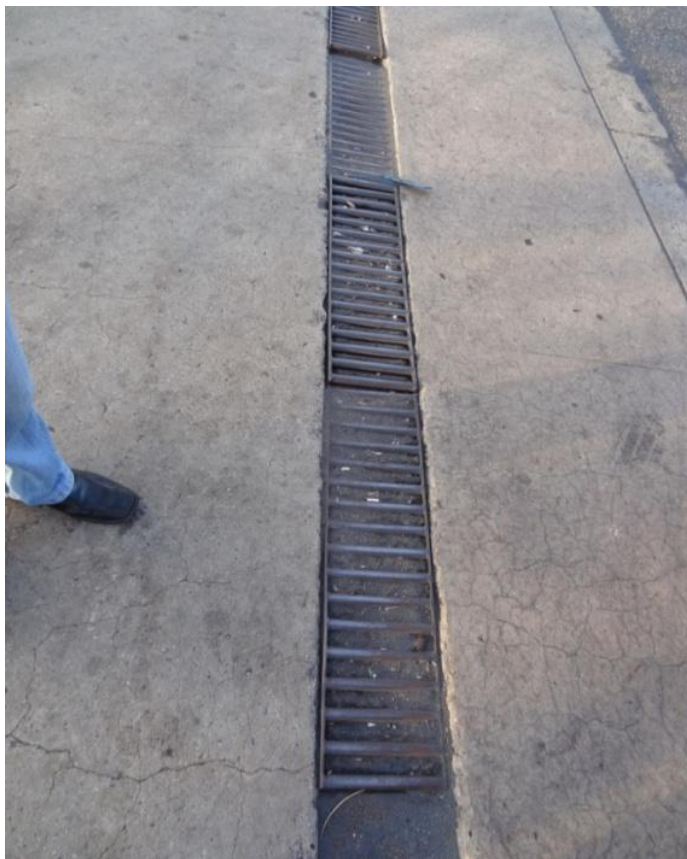
Figura 9 - Calha para escoamento de água pluvial
