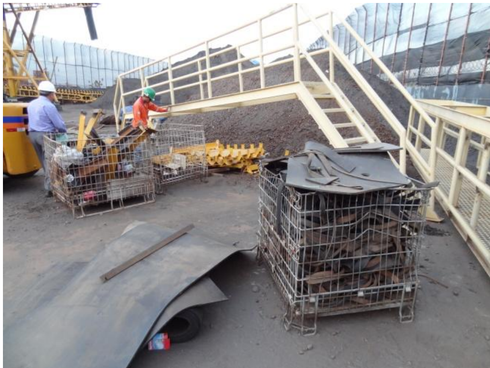
Figura 36 - Depósito temporário de resíduos
