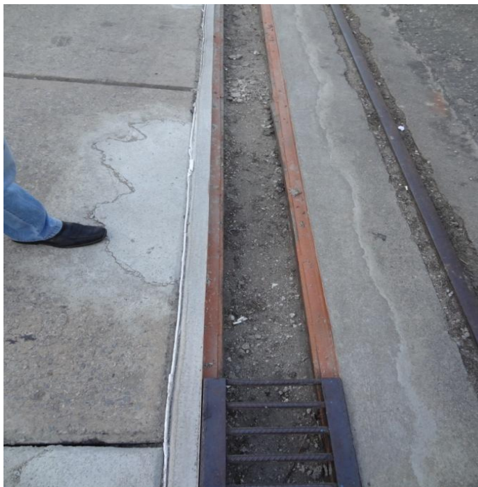
Figura 8 - Calha para escoamento de água pluvial
