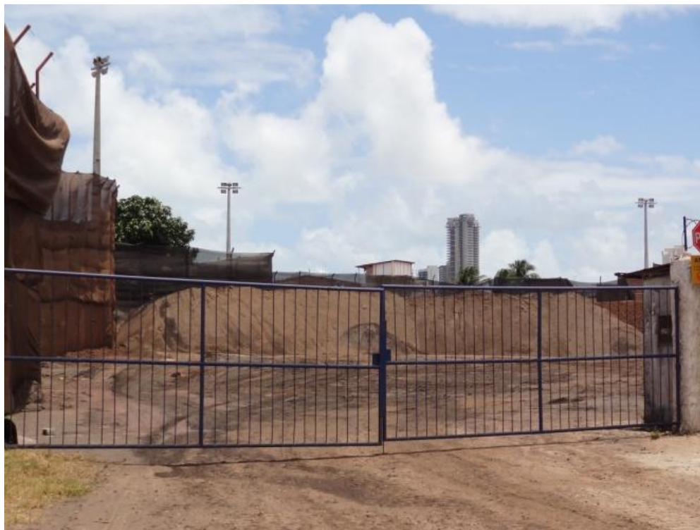
Figura 42 - Entrada do depósito de minério de ferro
