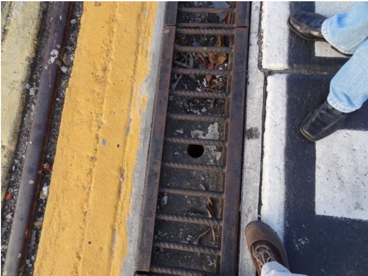
Figura 7 - Calha para escoamento de água pluvial
