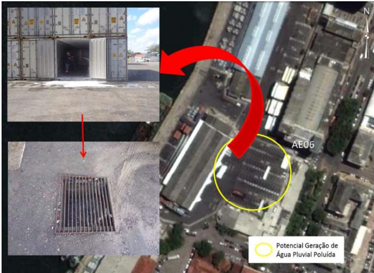
Figura 39 - Lavagem de containers . No detalhe a presença de água com detergente escoando direto para a drenagem pluvial
