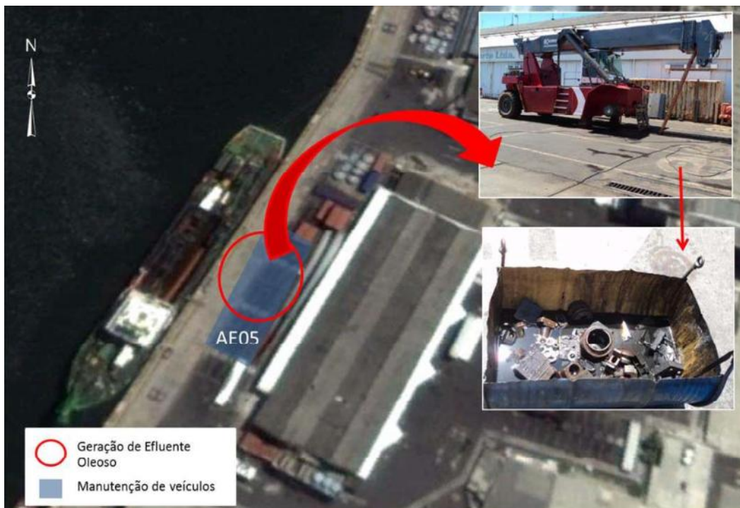
Figura 44 - AE05, área de manutenção de equipamentos. No detalhe o armazenamento inadequado do óleo residual
