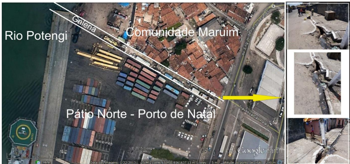
Figura 45 - escoamento de esgoto a céu aberto - Galeria sob o Pátio Norte
