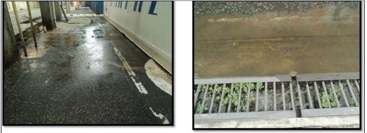
Figura 38 - Grãos de trigo carregados pela lavagem das esteiras e canaleta necessitando de manutenção
