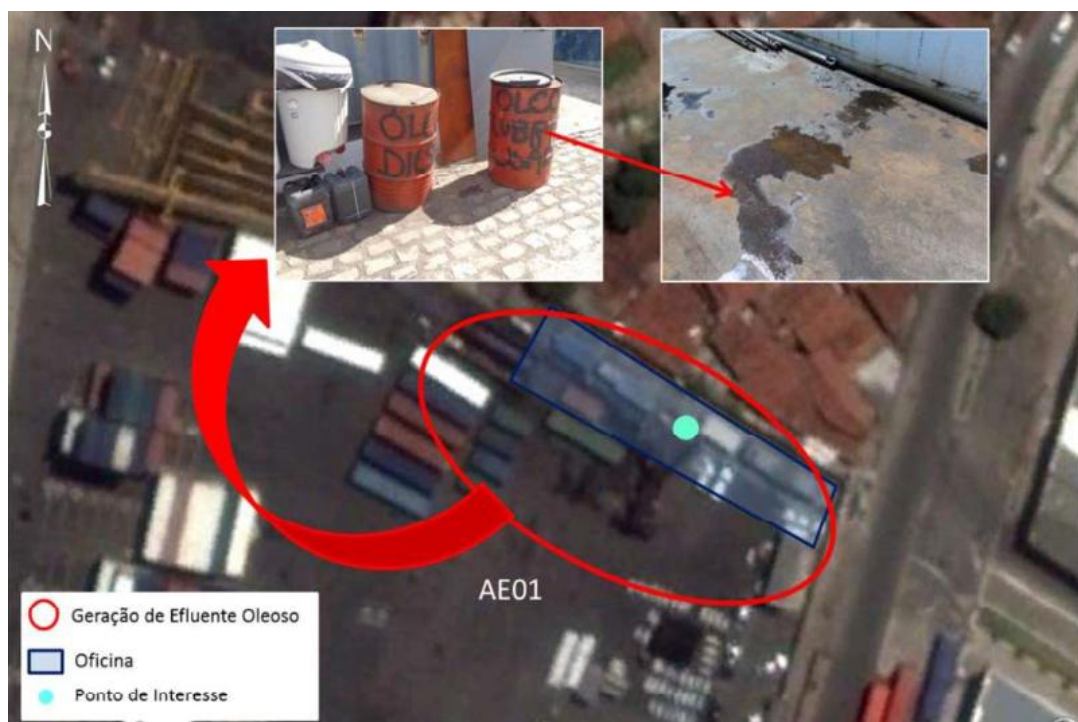
Figura 43 - AE01, área para manutenção de containers refrigerados. No detalhe presença de óleo no piso da oficina de containers .
