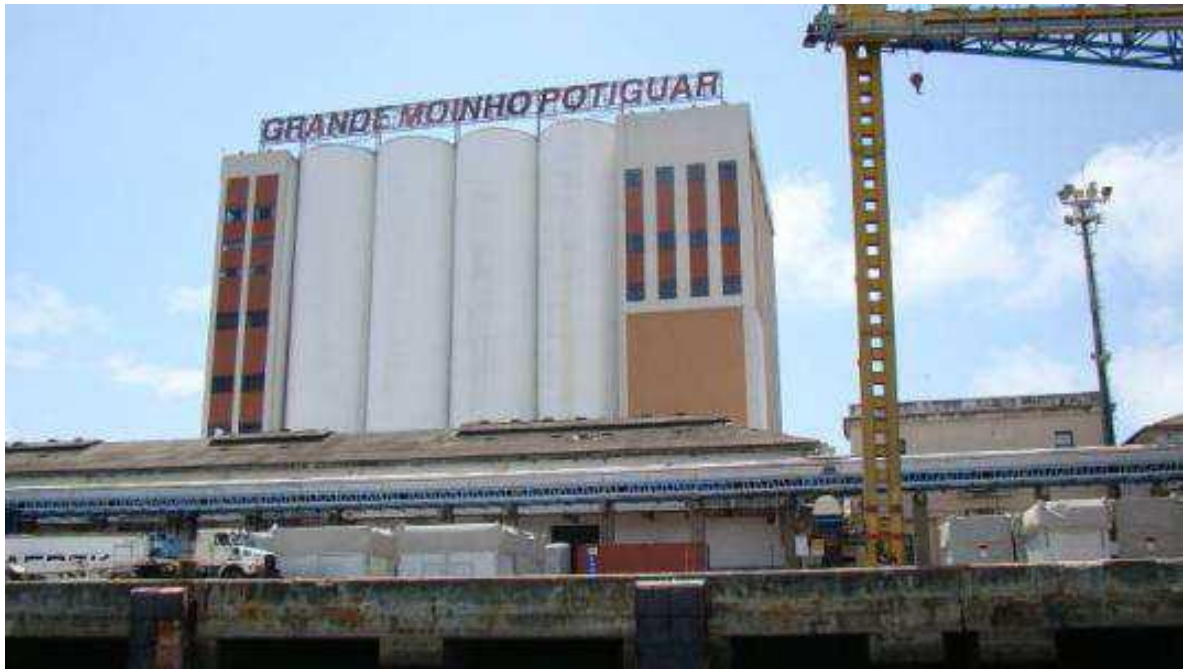
Figura 123 - Pier de atracação e Grande Moinho Potiguar
