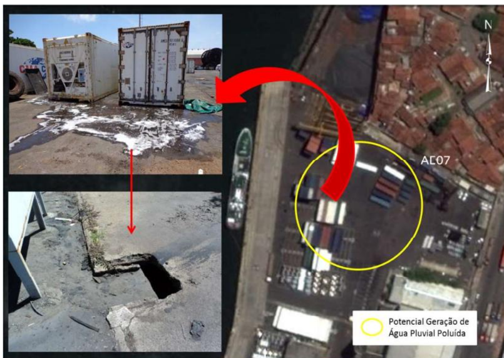
Figura 42 - AE07, lavagem de containers . No detalhe água com detergente escoado direto para a drenagem pluvial no local
