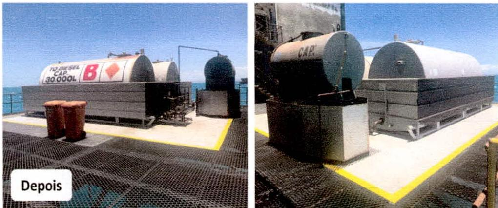
Figura 5 - Instalação do novo sistema de tancagem, com toda impermeabilização da área.
