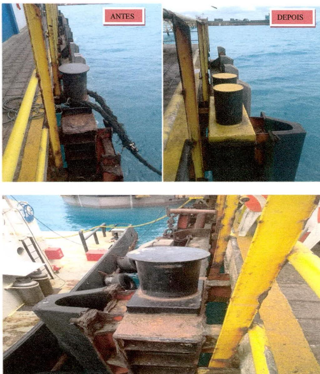
Figura 1 - Recuperação dos cabeços de atracação e substituição das defensas.
