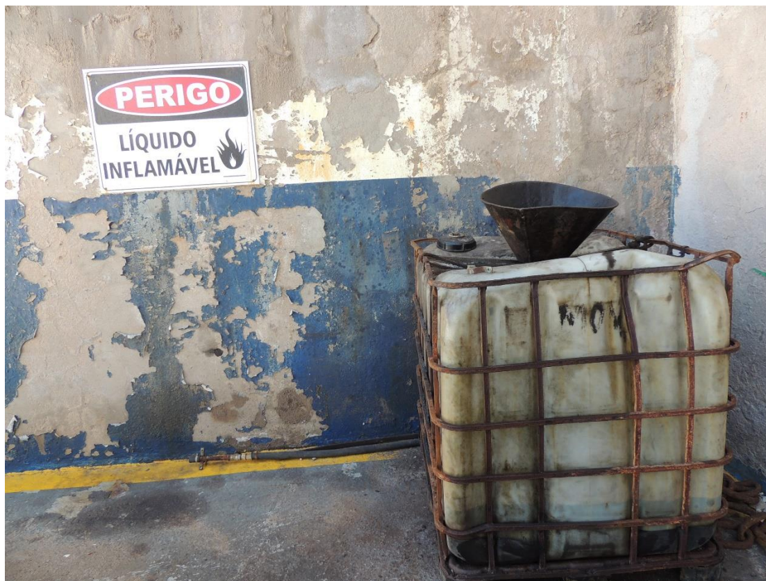
Foto 24 – Recipiente para armazenamento de resíduo líquido inflamável.
