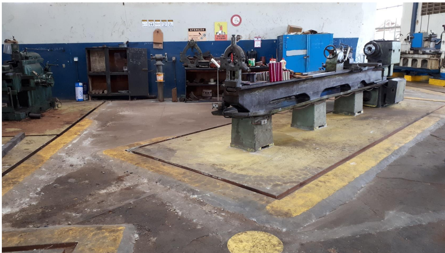
Foto 44 – Oficina mecânica. Equipamentos localizados em área delimitada com calha de drenagem com piso impermeabilizado.
