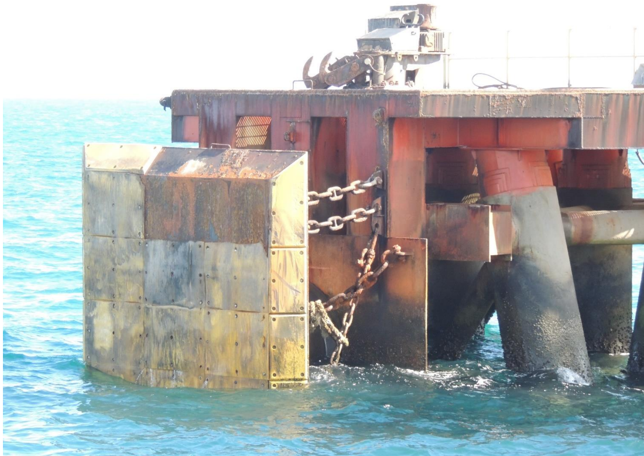
Foto 07 – Defesa número 01 recuperada e possui placa de ferro recoberta por material plástico tecnil.
