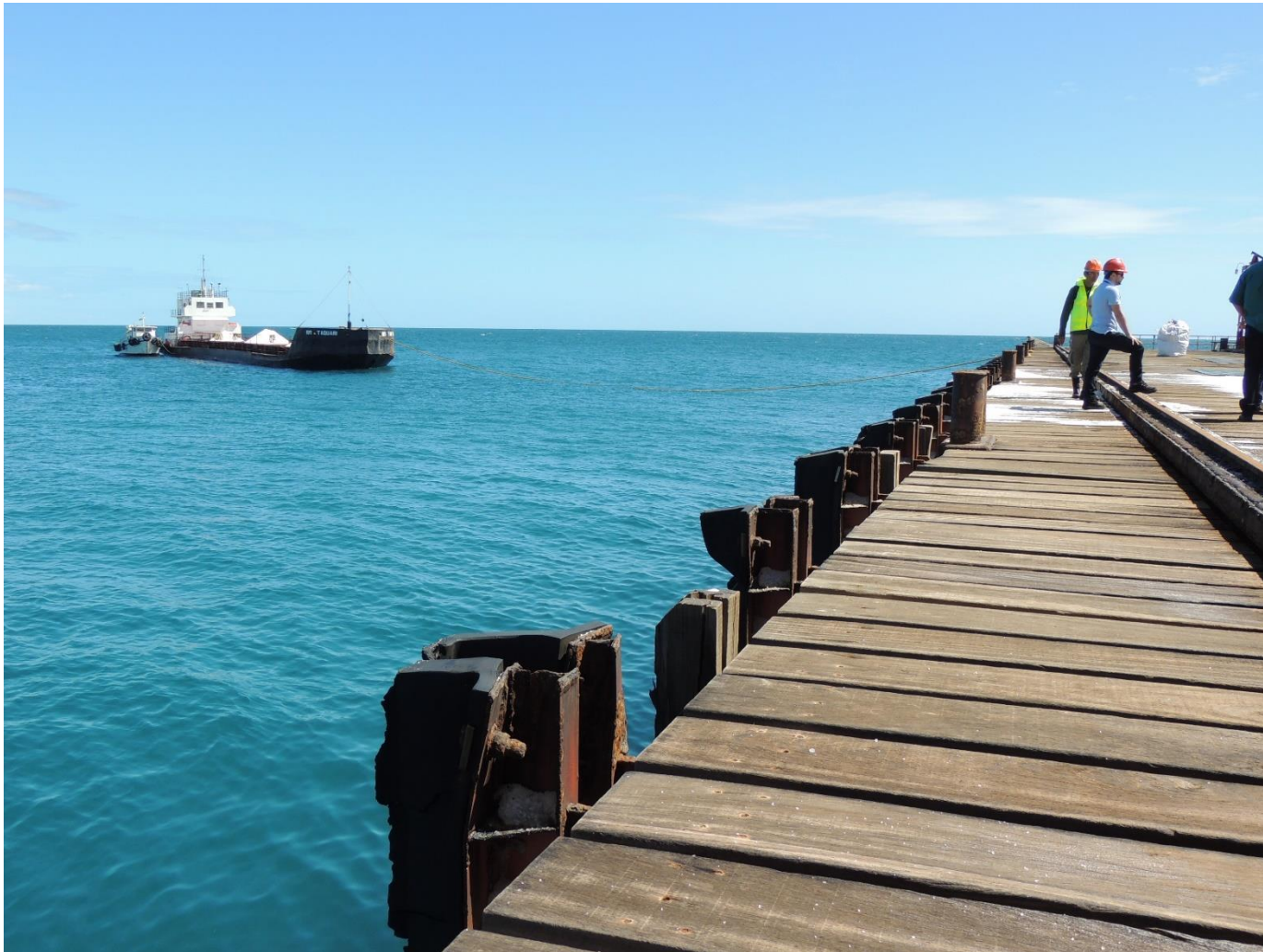
Foto 15 – Trecho do cais barcaça com defensas de material de borracha
