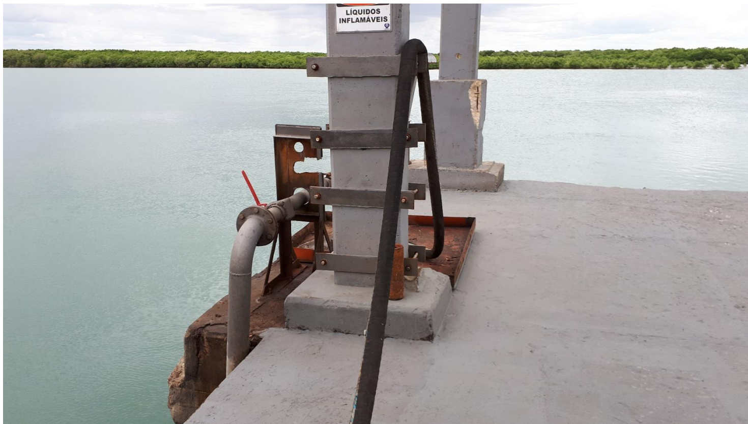
Foto 43 – Mangote para conectar o duto à embarcação.
