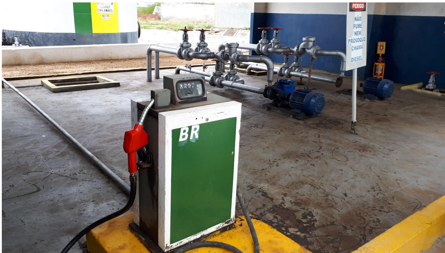
Foto 38 – Áreas destinadas as bombas da área de tancagem com piso impermealizado.
