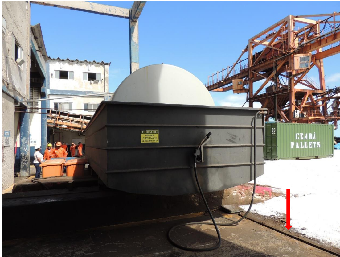
Foto 30 – Calha de drenagem na área da oficina onde as máquinas são abastecidas.
