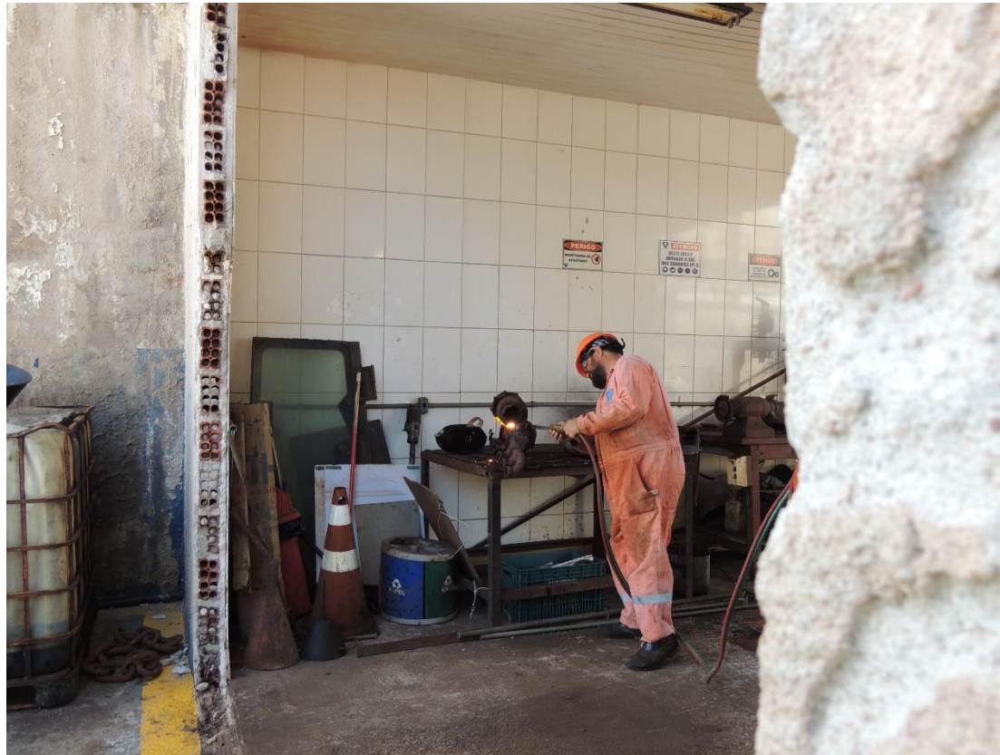
Foto 25 – Atividade de solda próxima à área de armazenamento de resíduo perigoso.
