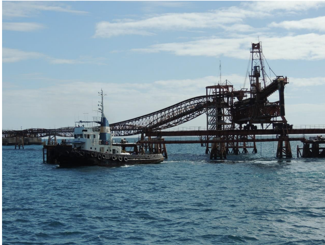
Foto 29: esteira que transporta o sal para carregamento nos navios.
