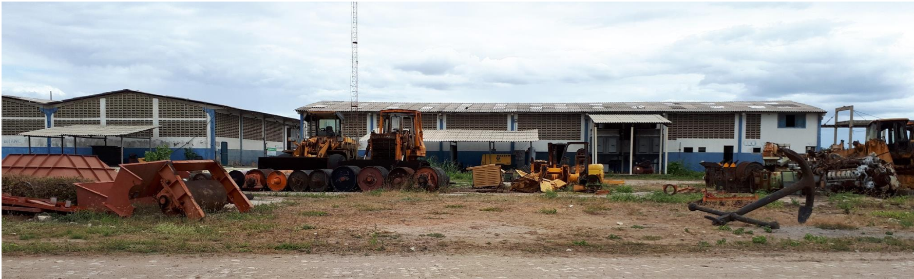
Foto 46 – Pátio da CODERN com máquinas sem uso.
