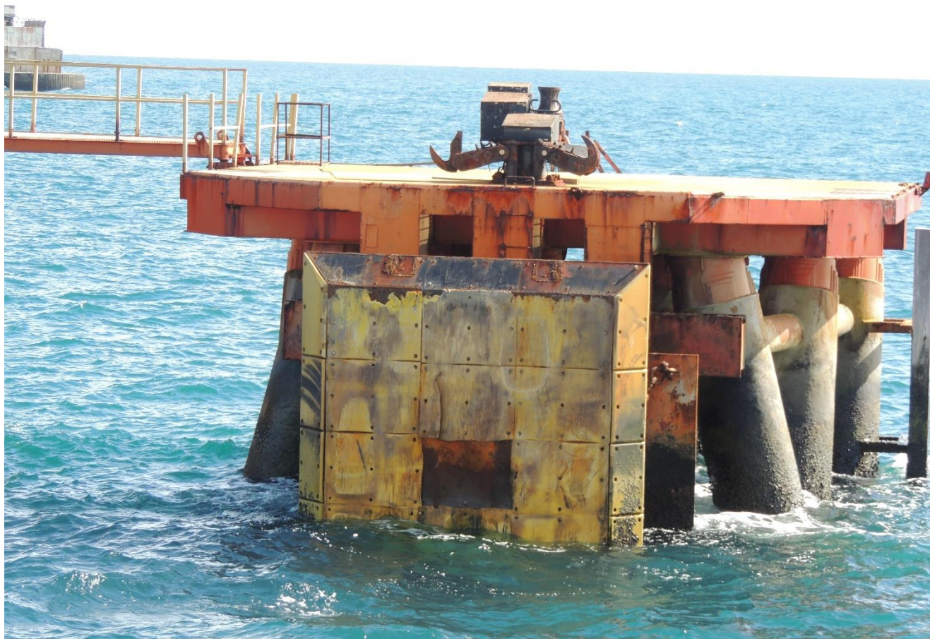
Foto 08 – Defesa número 05 recuperada e possui placa de ferro recoberta por material plástico tecnil.
