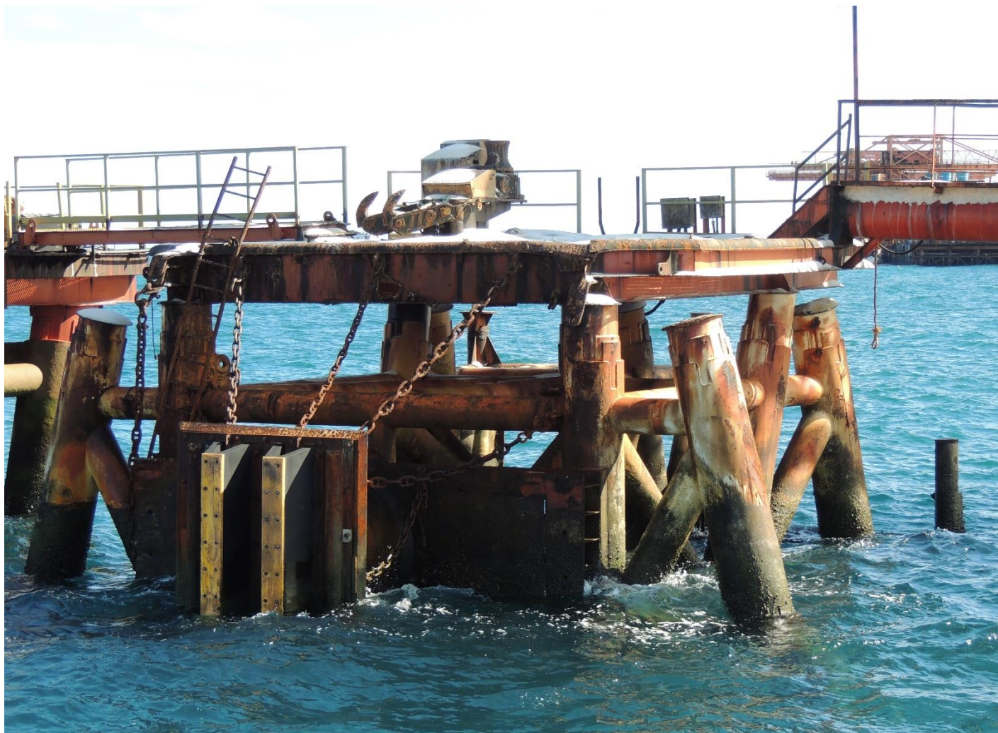
Foto 09 – Defesa número 03 recuperada com placa de ferro e estrutura de borracha para amortecimento. Defesa de menor porte em relação as 1 e 5.
