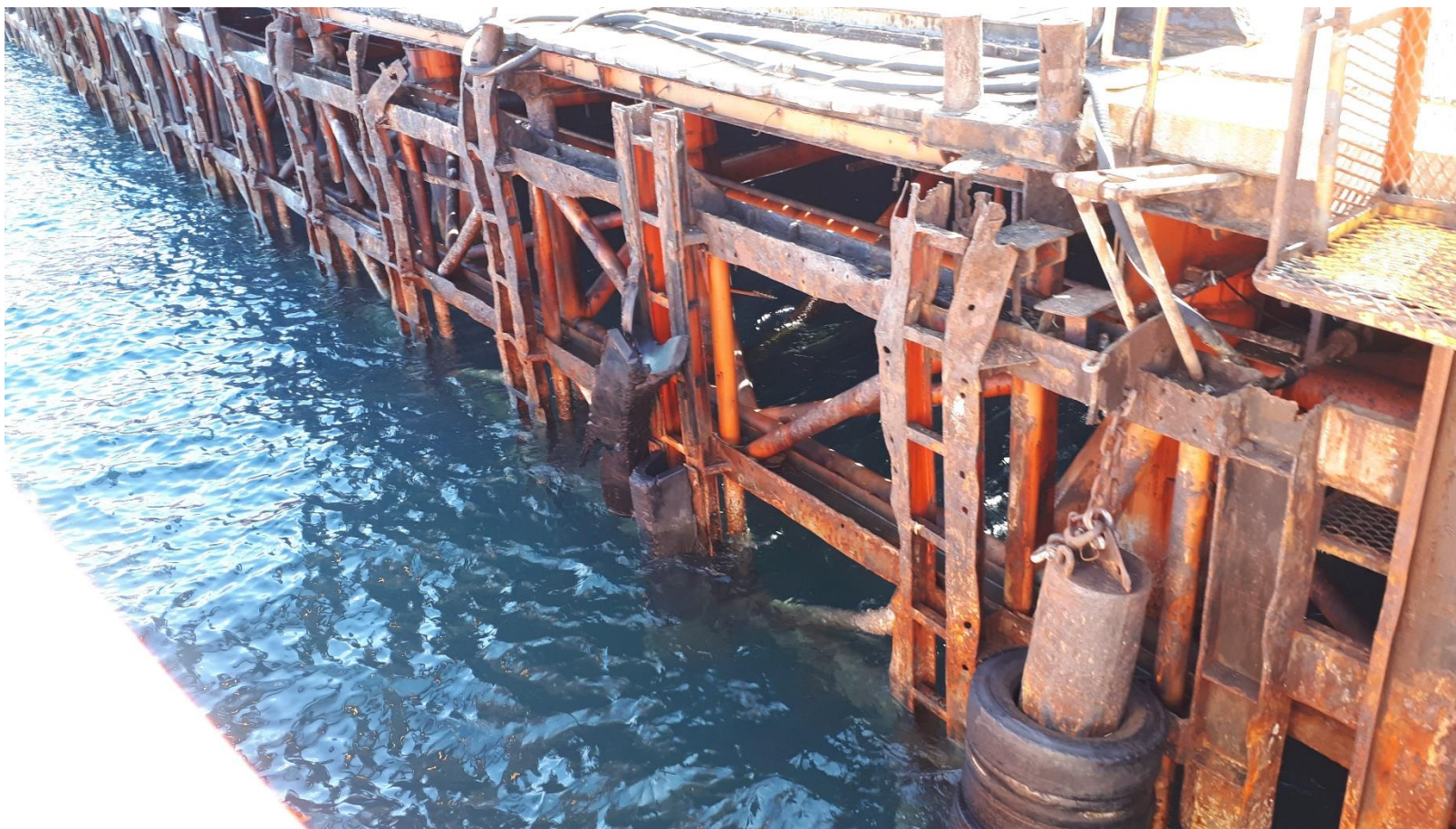
Foto 13 – Trecho do cais barçaça contíguo onde atracam as lanchas para desembarque de pessoal sem defensas.
