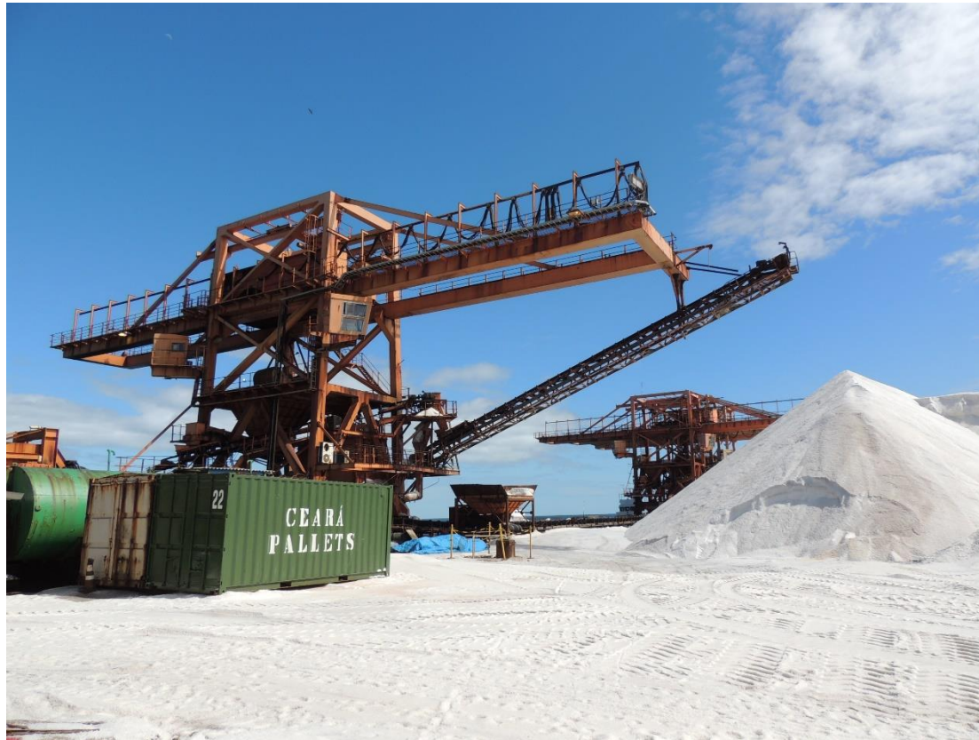
Foto 53 – Container com o material para contenção e recolhimento de óleo em mar localizado no Terminal.
