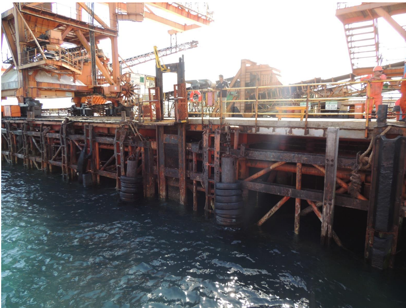
Foto 12 – Trceho do cais onde onde atracam as lanchas para desembarque de pessoal com desensas improvisadas por pneus.
