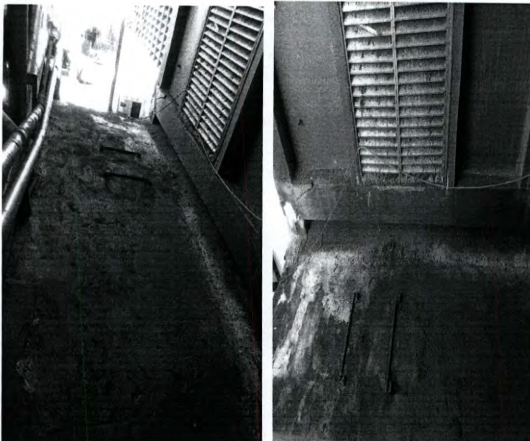
Figura 14. Cobertura do Setor de Geradores (A e B).
