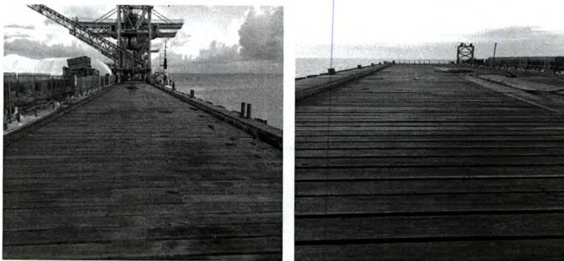
Figura 11. Cais dos Descarregadores de Barcaça (DBs) com a remoção do betume.
