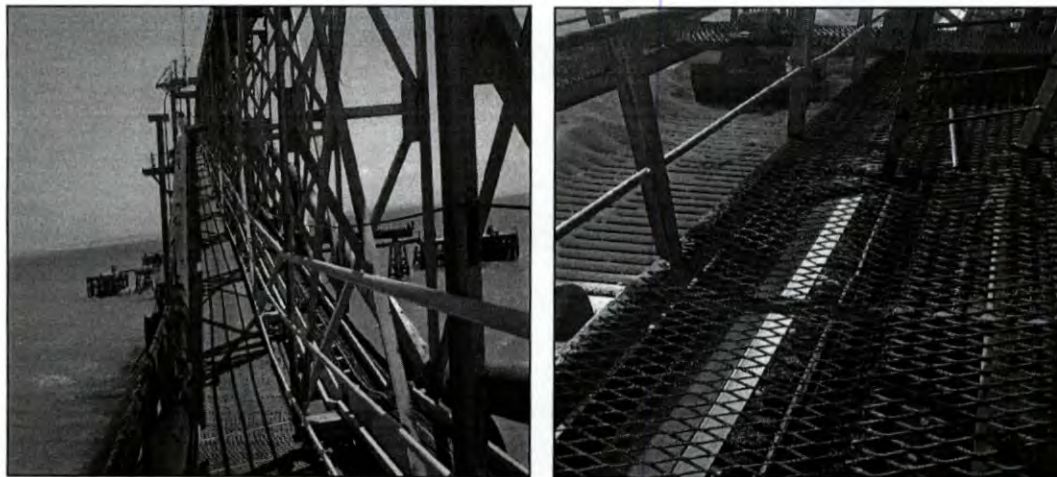
Figura 10. Grades do piso recuperado ao longo da ponte de carregamento. (A e B)
