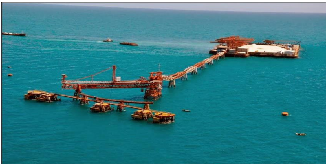
Imagem 19 – CN (é a estrutura final de todo o sistema transportador do porto)
