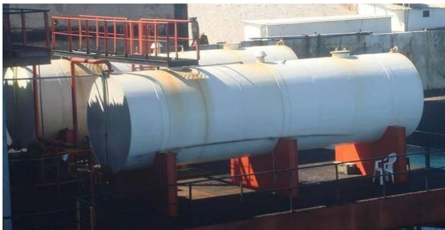
Imagem 27 – tanques de óleo Diesel
