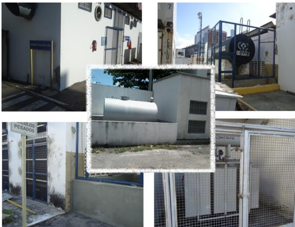
FIGURA 24: Subestações do Porto do Natal.
