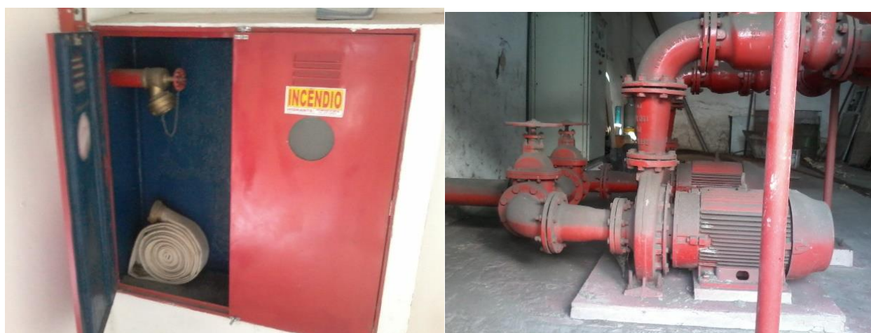
FIGURA 18: Sistema de Hidrantes.
