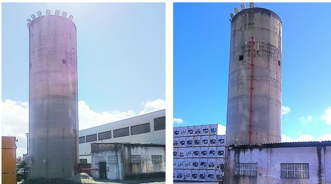
FIGURA 17: Reservatório de Incêndio situado no Castelo d'água.
