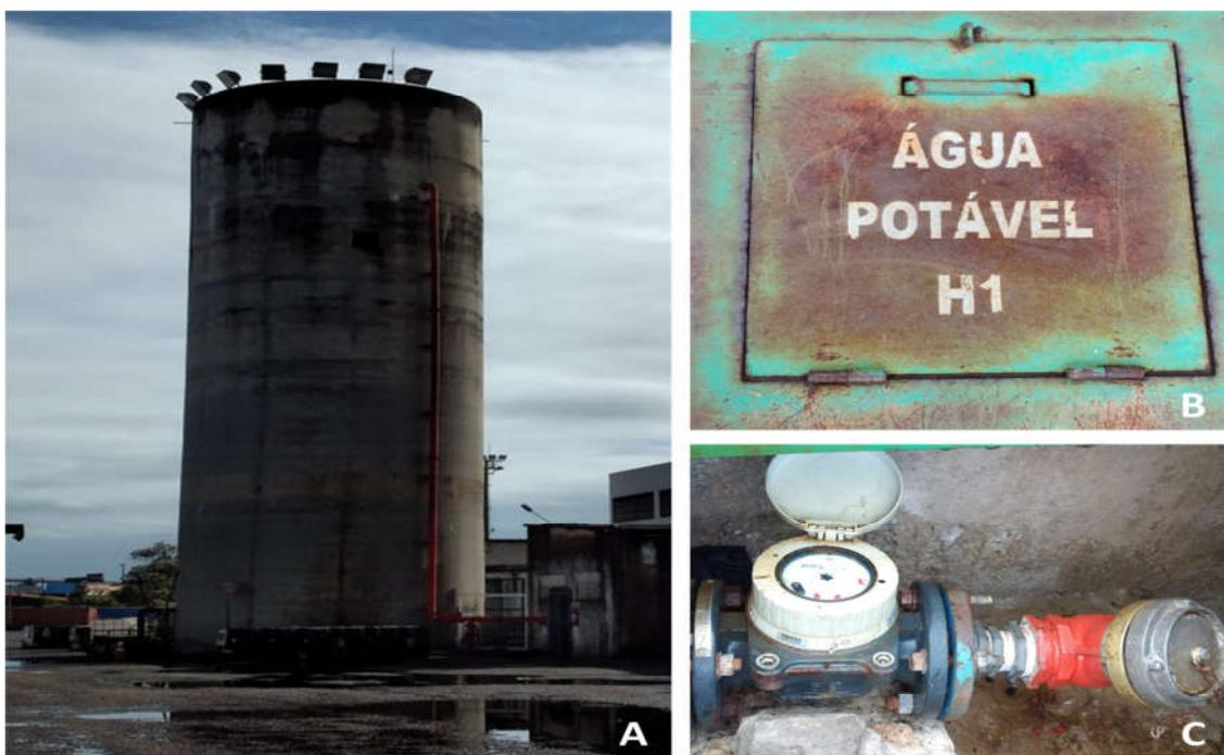
Figura 2. Foto do “Castelo d'água”, reservatório de água superior do pátio portuário, Hidrante situado na faixa de cais, usado para o abastecimento de embarcações.
