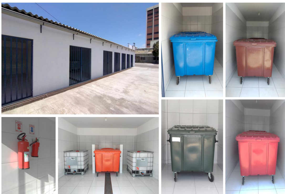
Figura 6. Área de Transbordo Temporário (ATT) do Porto de Natal.
