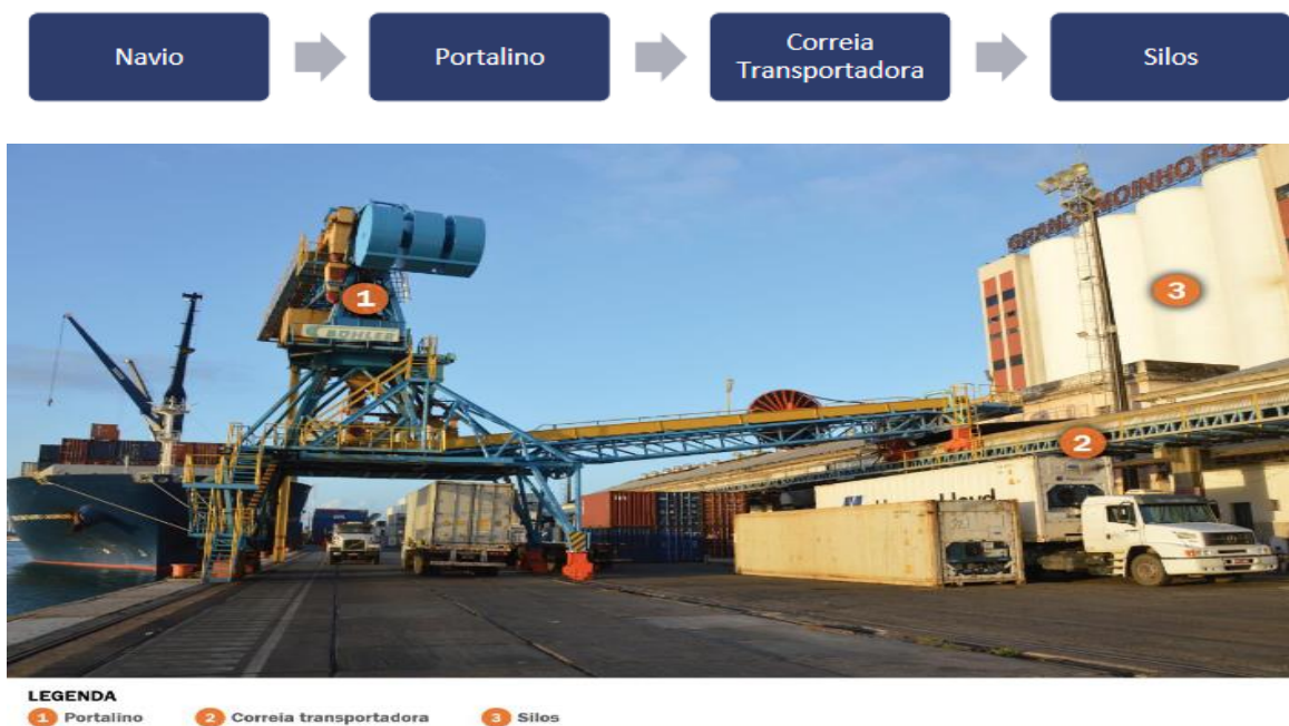
Figura 4. Fluxo e equipamentos da operação com trigo (Fonte: Plano Mestre - Porto de Natal/2018)
