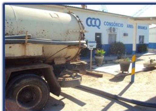
Figura 2 – Esgotamento, limpeza e manutenção das fossas do canteiro onshore por empresa especializada devidamente licenciada.
