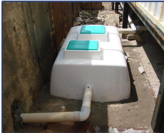
Figura 1 – Estações de Tratamento de Efluentes (ETE) compactas instaladas no Terminal Salineiro de Areia Branca (TERSAB).
