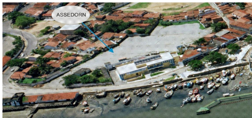
Fotografia 30 – Instalações Portuárias Pátio “ASSEDORN”
