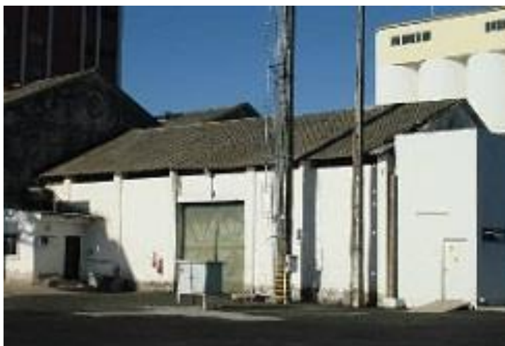
Fotografia 15 - Galpão nº 02 – lado do cais
