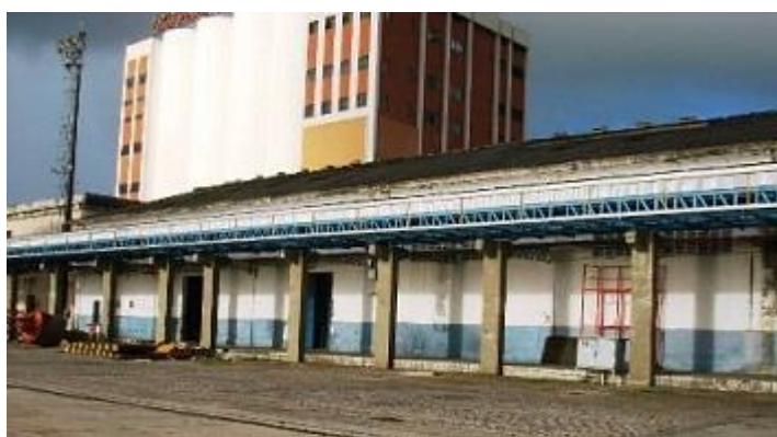
Fotografia 16 - Armazém nº 02 – lado do cais
