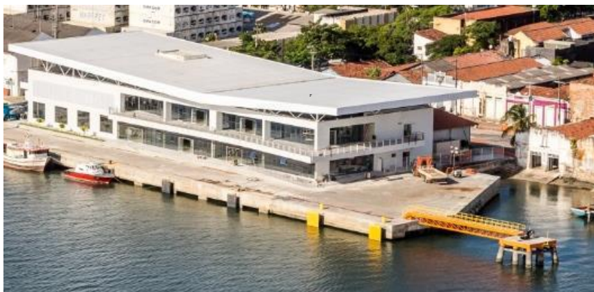
Fotografia 09 – Terminal Marítimo de Passageiros – fachada fronteiriça ao cais
