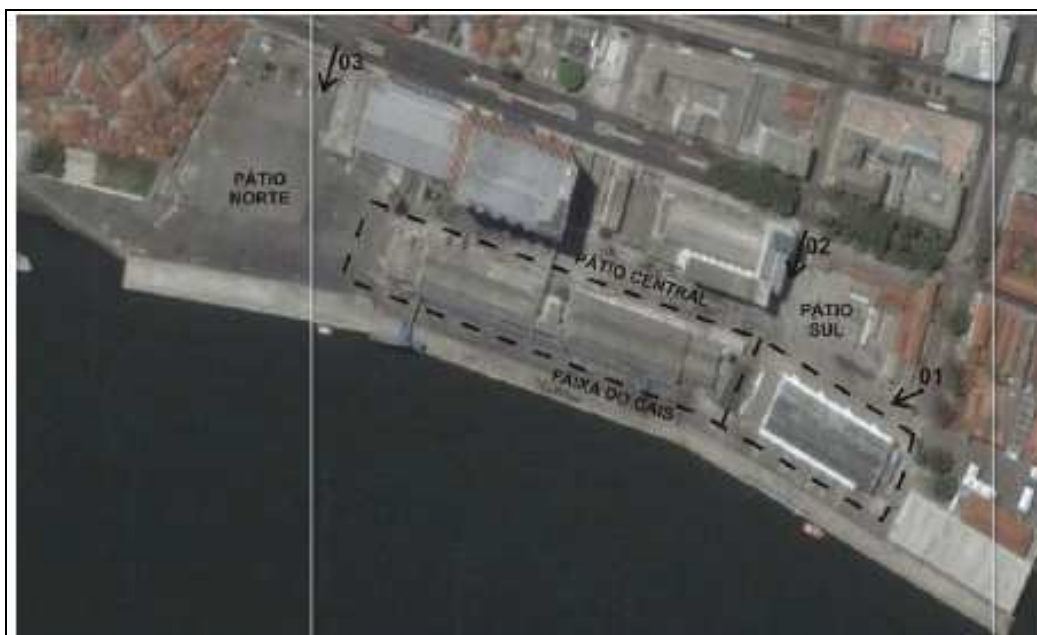
Foto 5 - Vias internas de circulação e acessos ao Porto de Natal Fonte: Plano de Desenvolvimento e Zoneamento – PDZ, 2010
