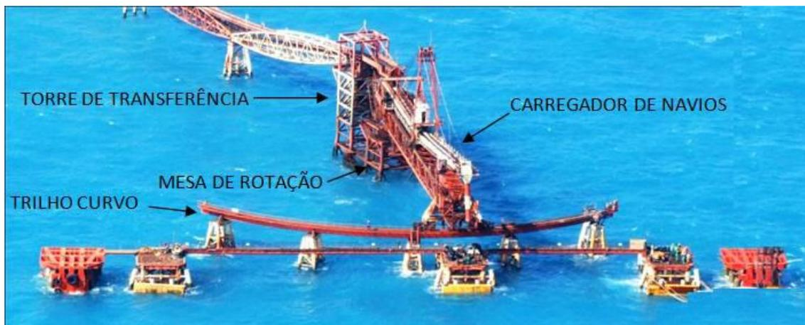
**Figura 31.** Estruturas e Equipamentos Utilizados na Movimentação de Sal
